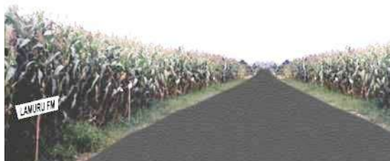
Bagian Jalan dengan Aspal Butas (hotmix)
