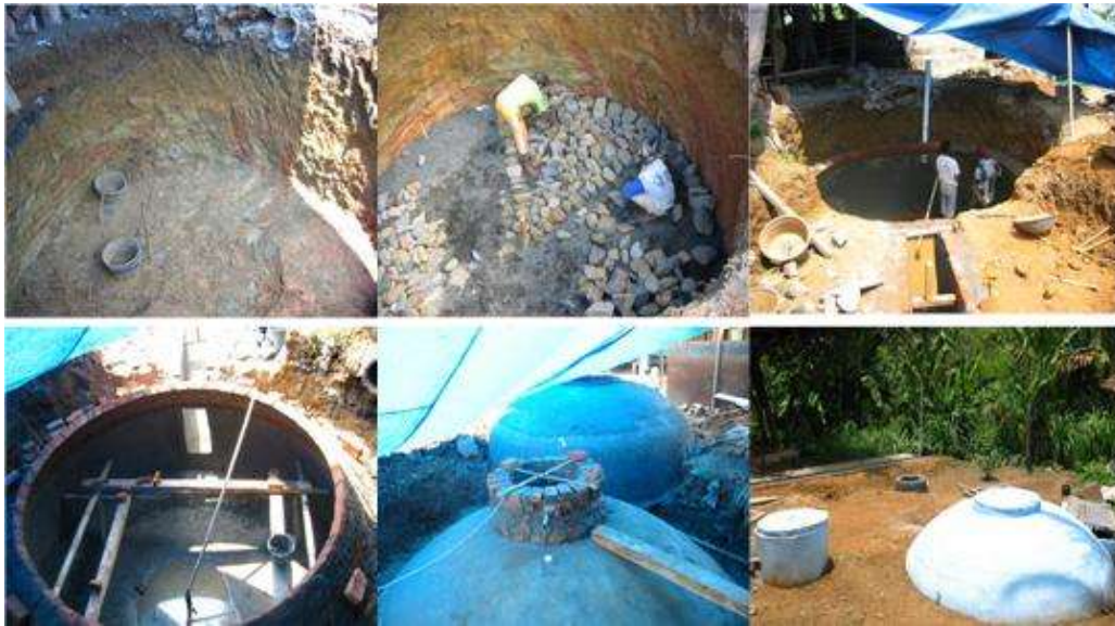
Gambar 4. Tahap-Tahap Pekerjaan Pembuatan Digester di Ponpes Darul Falah Ciampea
