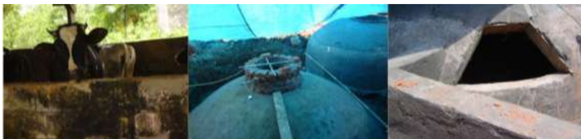
Gambar 10. Digester biogas dan pengeluaran sludge di wilayah Boyolali
