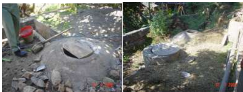
Gambar 8. Digester biogas jenis fixed dome di wilayah Semarang
