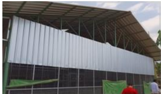
Kandang pembibitan yang permanen dibangun oleh pak Junaidi, sebagian biaya pembangunan kandang adalah swadaya
